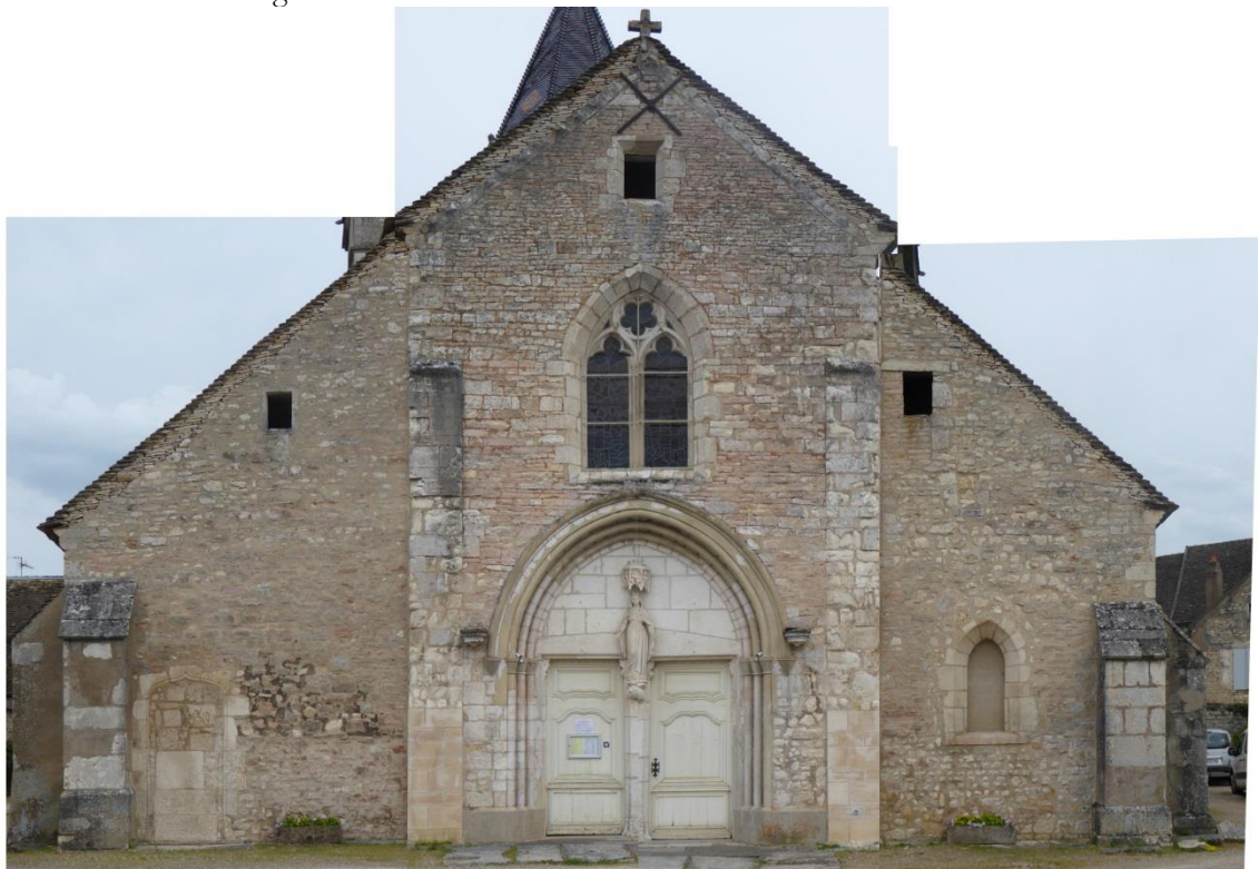
Ortho-photographie façade ouest
