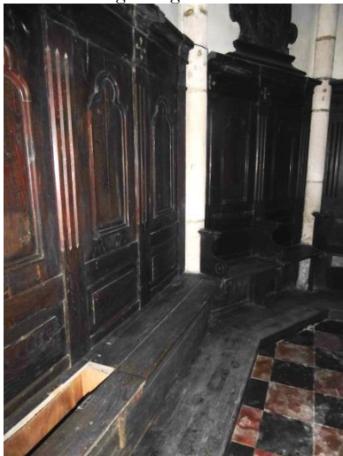
Parties basses des bancs d'œuvre et estrades blanchies et souvent infestées de vrillettes.
