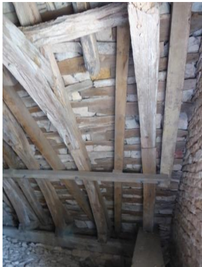
Sous face Nord de la nef- chevrons de renfort de contreventement-et d'espacement- lattes de voliges non croisées sur chevron- entraxe sup. à 40cm
