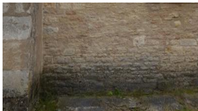
Mur Nord, drain en dalles de pierre rabattant l'eau + effet de rejaillissement, et pierres tachées par l'ancienne plinthe en ciment. Les dallettes de pierre ne sont pas inclinées.
