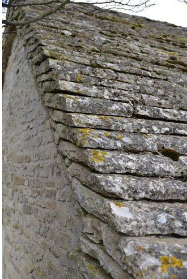
Laves anciennes épaisses et régularisées en technique savante
