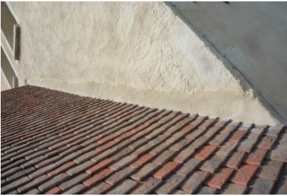
Exemple de rive avec solin chaux et dévirure au pied d'un clocher- travaux à Gergy, Ets Covre- Moe Fraisse
