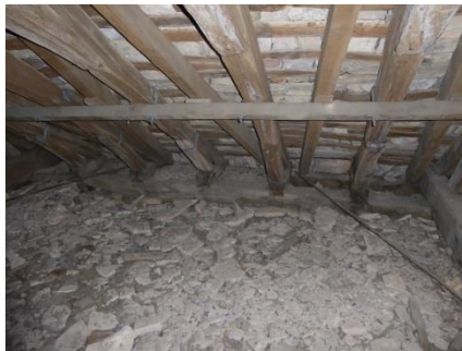
2e travée de la nef- patins sortis de leur assemblage en queue d'hirondelle et surcharge du cailloutis sur la croisée.
