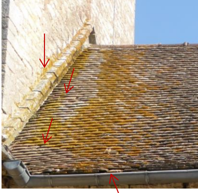
Examen du toit du chœur, fort coyautage sur l'extension, bris de tuiles vers le solin, mousses, mauvaise exécution des doublis en bas de pente.
