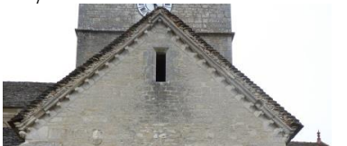
Modillons à crochet restaurés
