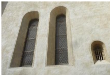
Remplacement des raquettes en fil laiton, et remise en place en retrait
