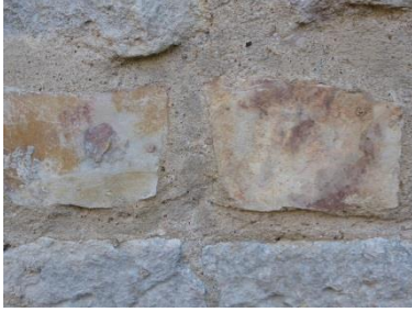
Pierres ayant subi l'incendie, amollissement des angles, rougeurs de rubéfaction.
