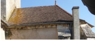
Examen du toit du chœur, fort coyautage sur l'extension, bris de tuiles vers le solin, mousses, mauvaise exécution des doublis en bas de pente.
