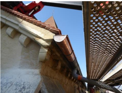
Reprise coyau et doublis sur une corniche.
