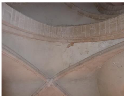
Dégradations des enduits contre l'arc triomphal dans le chœur, amenant des chutes de matériaux humides sur l'autel.
