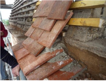
Révision d'égoût à triple doublis scellé, essai de convenance.
