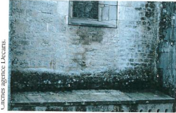
Rapport diagnostic Avallon par Decaris Tunnel d'assainissement ventilé
