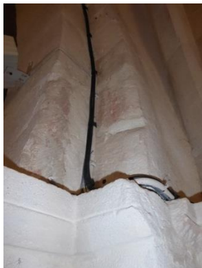
Arcature de la nef- pierre d'origine roussie et éclatées aux angles, s'arrondissant, et reprise badigeonnées des moulures du tailloir aux angles nets
