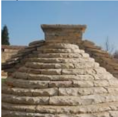
Laves modernes en technique savante, assouplies par une taille éclatée en nez de lave
