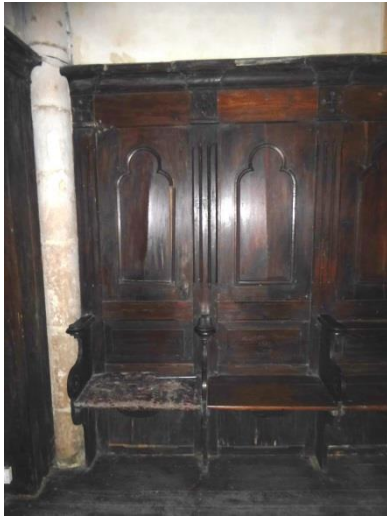
Panneaux hauts gerçés, et attaques xylophages des panneaux bas des plinthes.
